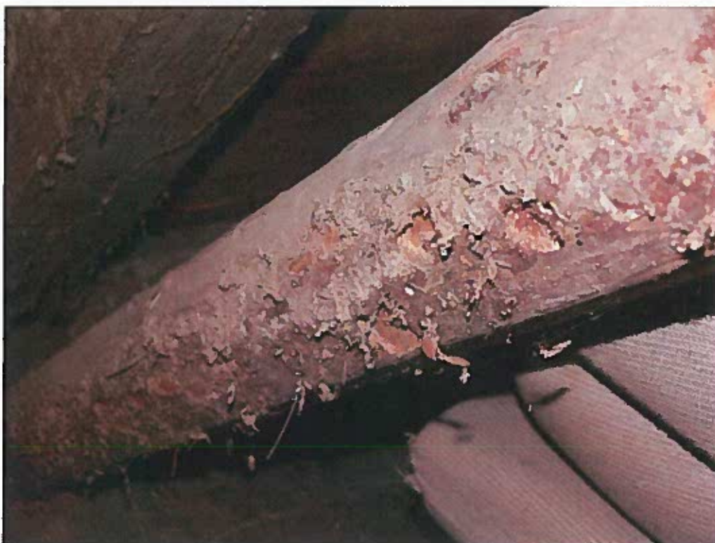
Příklad neodkornění prvků konstrukce
